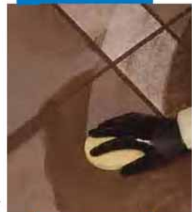
تمیز کردن سطح کاشی و بندها به وسیله اسفنج
