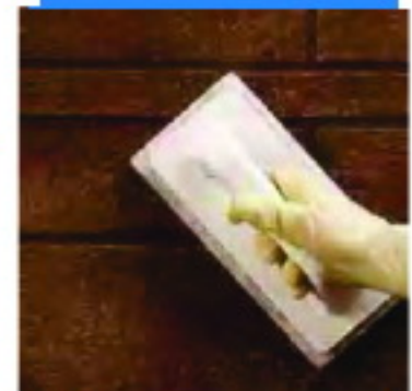
تمیز کردن سطوح و بندها به وسیله Scotch Brite وقتی که تا اندازه ای خشک شده اند.
