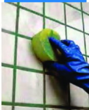
تمیز کردن بندها به وسیله اسفنج.
