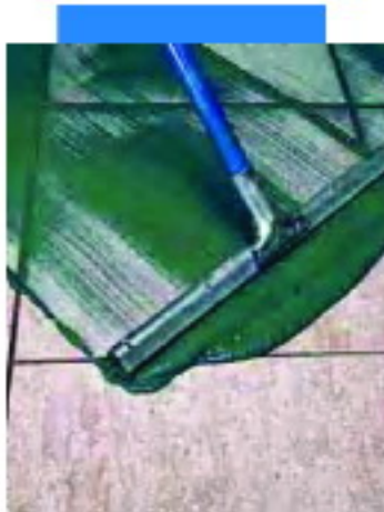
مالیدن Ultracolor Plus به روی کف با طی لاستیکی
